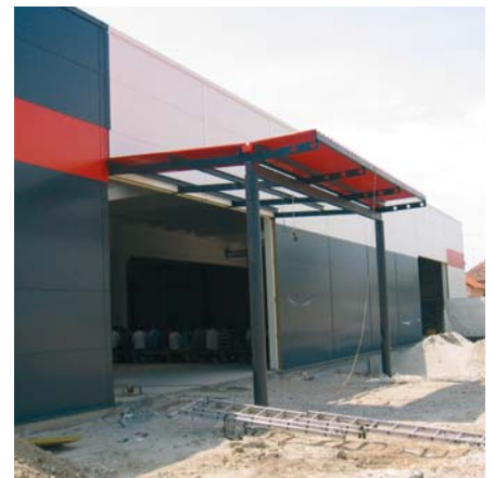
U trgovačkom centru Bono instalirana su dva Vaillantova fasadna uređaja od 24 kW
