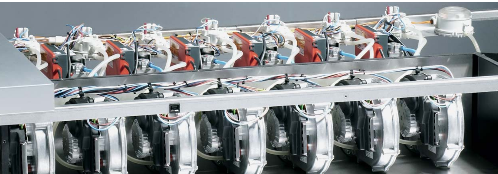
Fleksibilni moduli su u svom radu međusobno neovisni pa tako tijekom rada uređaja može raditi samo jedan modul ili svi, ovisno o zahtjevu za toplinom
