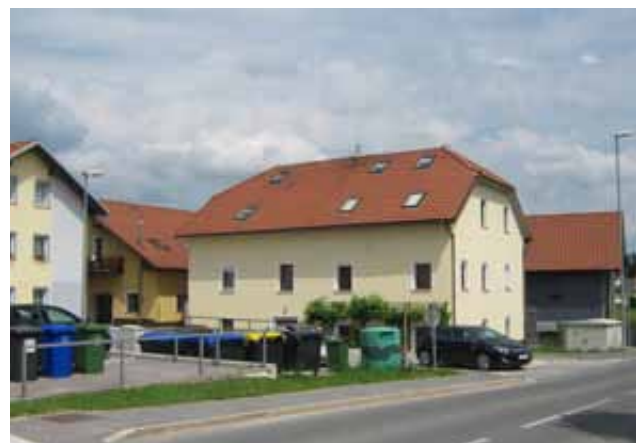
Objekt pored Logaščice, gdje je ugrađeno 6 ecoTEC aparata
