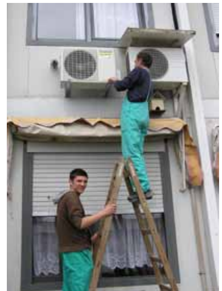
Montaža klima uređaja
