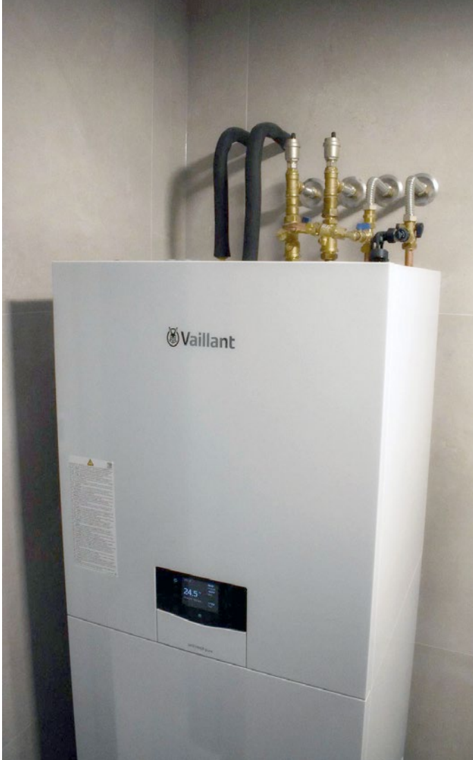
Instalacija odrađena za 5
